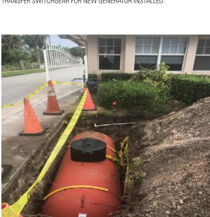
HAVERHILL ROAD GUARDHOUSE- 500 GALLON UNDERGROUND PROPANE TANK INSTALLED ON 7/30/20.
